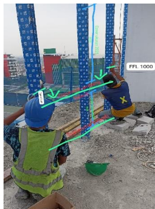
Gambar 9 Penentuan Titik Transome
