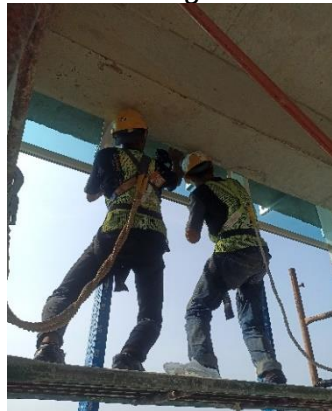
Gambar 11 Proses Pemasangan Kaca
