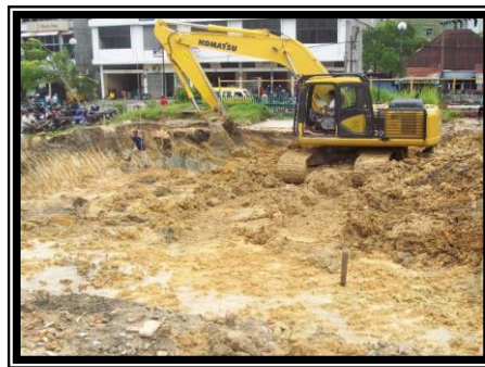
Gambar 5 : Pengerjaan Basement Tahun 2010
