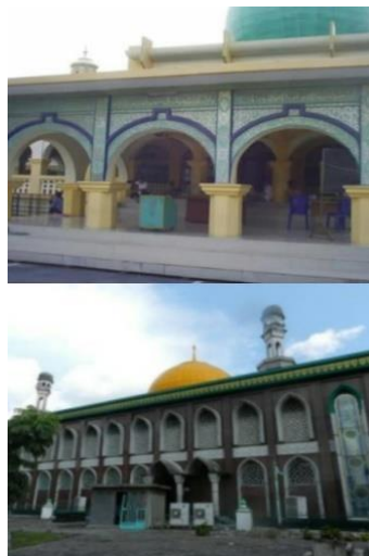
Gambar 1: Bangunan Masjid Raya Senapelan Pekanbaru Tahun 2009 (atas) dan 2017 (bawah)
