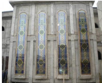
Gambar 4 : Kondisi Fisik Masjid Raya Senapelan Pekanbaru Tahun 2009
