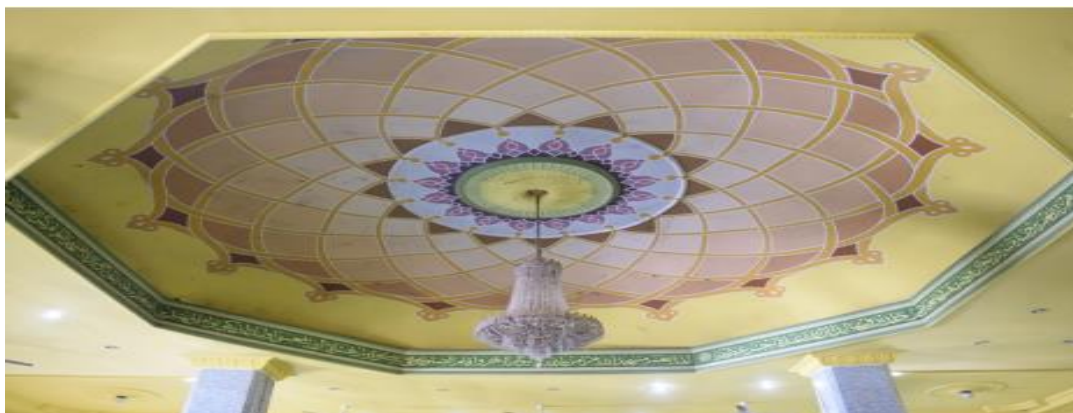
Gambar 4. Bagian Atas Sokoguru Sultan Sulaimaniyah Sumber: Dokumentasi Tim Penulis
