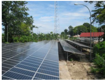
Gambar 2. Modul Sel Surya PLTS Pulau Karanrang.
