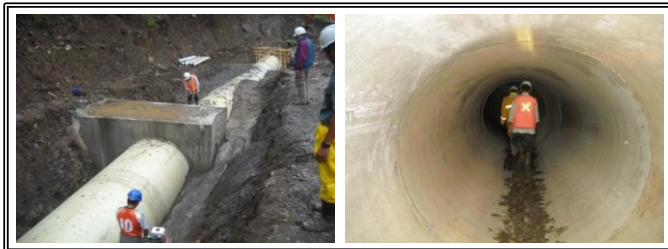
Gambar 4. Kondisi bangunan Pipa Waterway (Saluran Pembawa)
