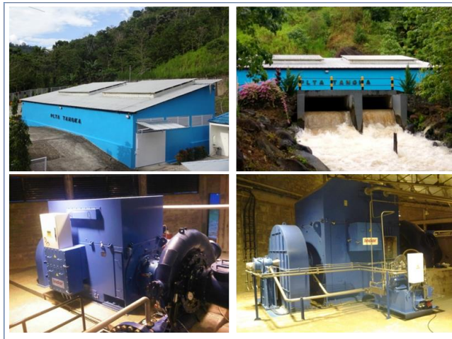
Gambar 5. Kondisi bangunan Power House PLTA Tangka
