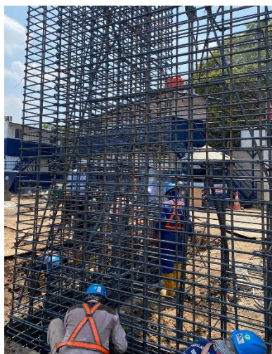
Gambar 12. Pemasangan Tulangan Yang Sudah Dirakit
