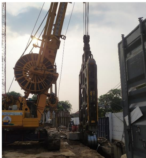
Gambar 4. Proses Penggalian Lubang Diaphragm Wall
