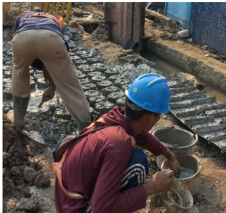
Gambar 11. Pembuatan Tahu Beton
