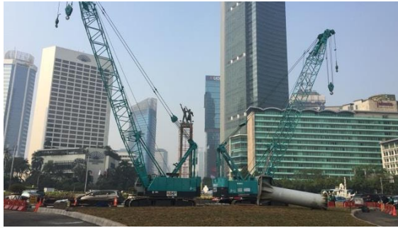
Gambar 7. Pembongkaran JPO Bundaran HI
