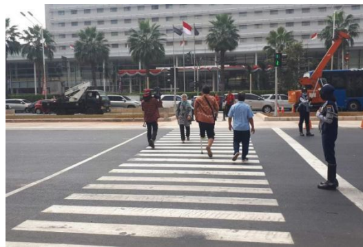
Gambar 8. Pembangunan Pelican crossing di JL. MH Thamrin
