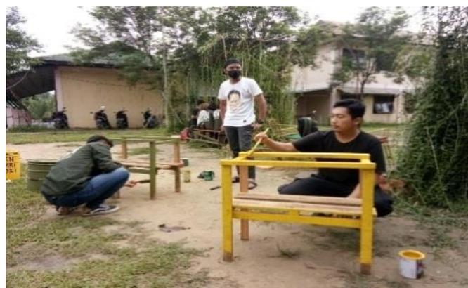
**Gambar 4. Proses Pembuatan Alas Tong Sampah dan Pengecatannya**
