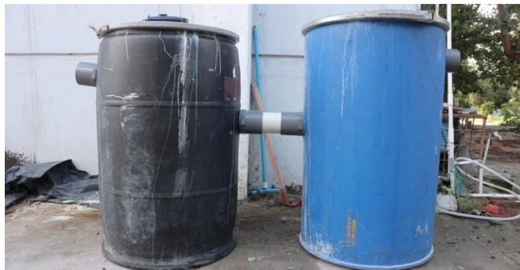
**Gambar 1. Tampak depan tangki septik bio-porta dalam skala lapangan.**
