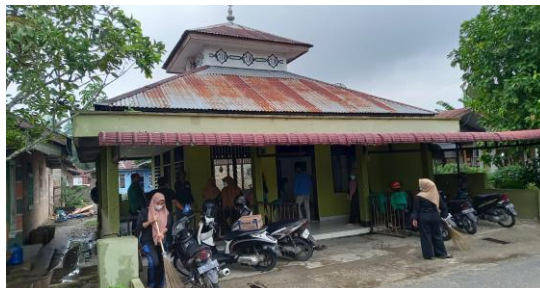
Gambar 1. Pembersihan Tempat Ibadah Dusun Tanah Rendah
