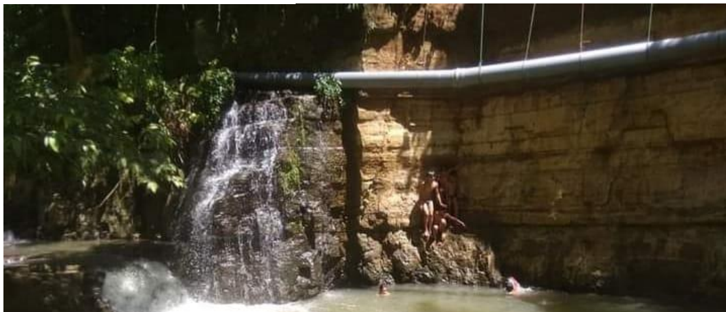
Gambar 5 Data Pipa air PDAM di Nagari Tanjung Barulak
