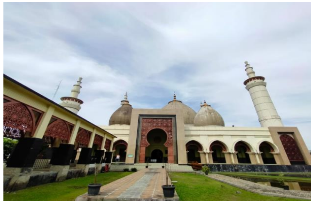
Gambar 1. Bangunan Masjid Islamic Center Al-Ihsan Sumber : Dokumentasi Narasumber
